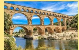
Los acueductos romanos permitieron abastecer de agua a las zonas urbanas
